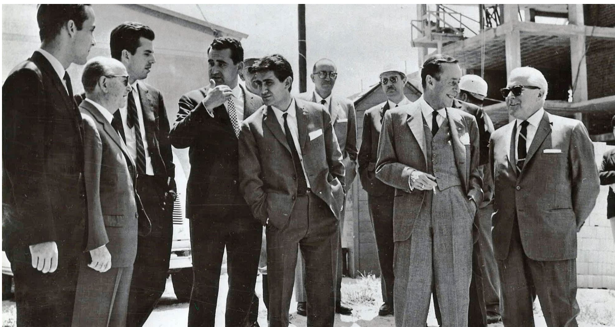
Visita de obra del Colegio Mayor Jaime del Amo en la Ciudad Universitaria de Madrid (1964-1968). Archivo Familiar Blanco Soler, imagen cedida por Silvia Arbaiza Blanco-Soler
