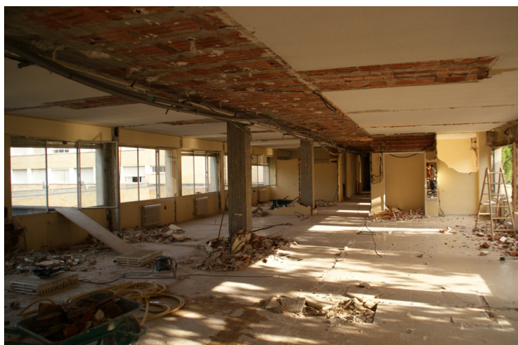
El colegio en obras. Curso 2009-2010
